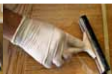
Eliminar agua sucia y restos de lijado
