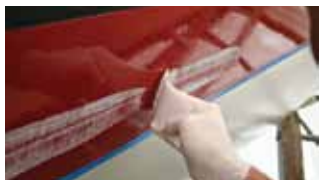
Enmasillado en la línea de flotación
