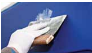
Enmasillado con el uso de una llana
