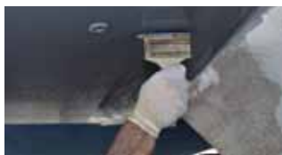
Extender High Protect en direcciones contrarias con brocha (opcional)
